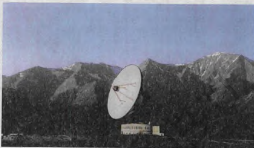
59- rasm. Jizzax viloyati Zomin tog‘lari etagidagi Supa degan joyda qurilayotgan, metall ko‘zglasining diametri 70 metrli radioteleskop.
