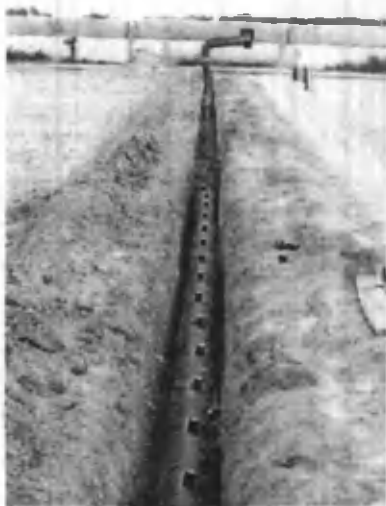
24-rasm. Temir-beton novdan suv olinib, suv egatlarga tuproq ostidan taqsimlanadigan tizimning ko'rinishi.
