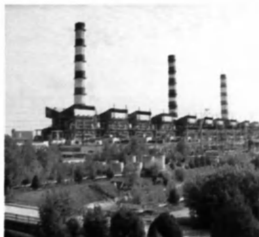
Тошкент иссиқлик электр станцияси.
