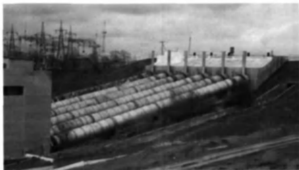
Қарши магистрал канали 7-насос станцияси.
