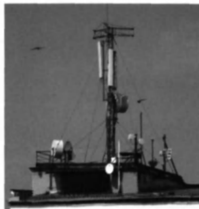
Мобил телефон алоқасининг қабул қилгич-узаткич антенналари.
