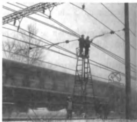
7.7-rasm. Kontakt tizimlarni joriy ta'mirlash
